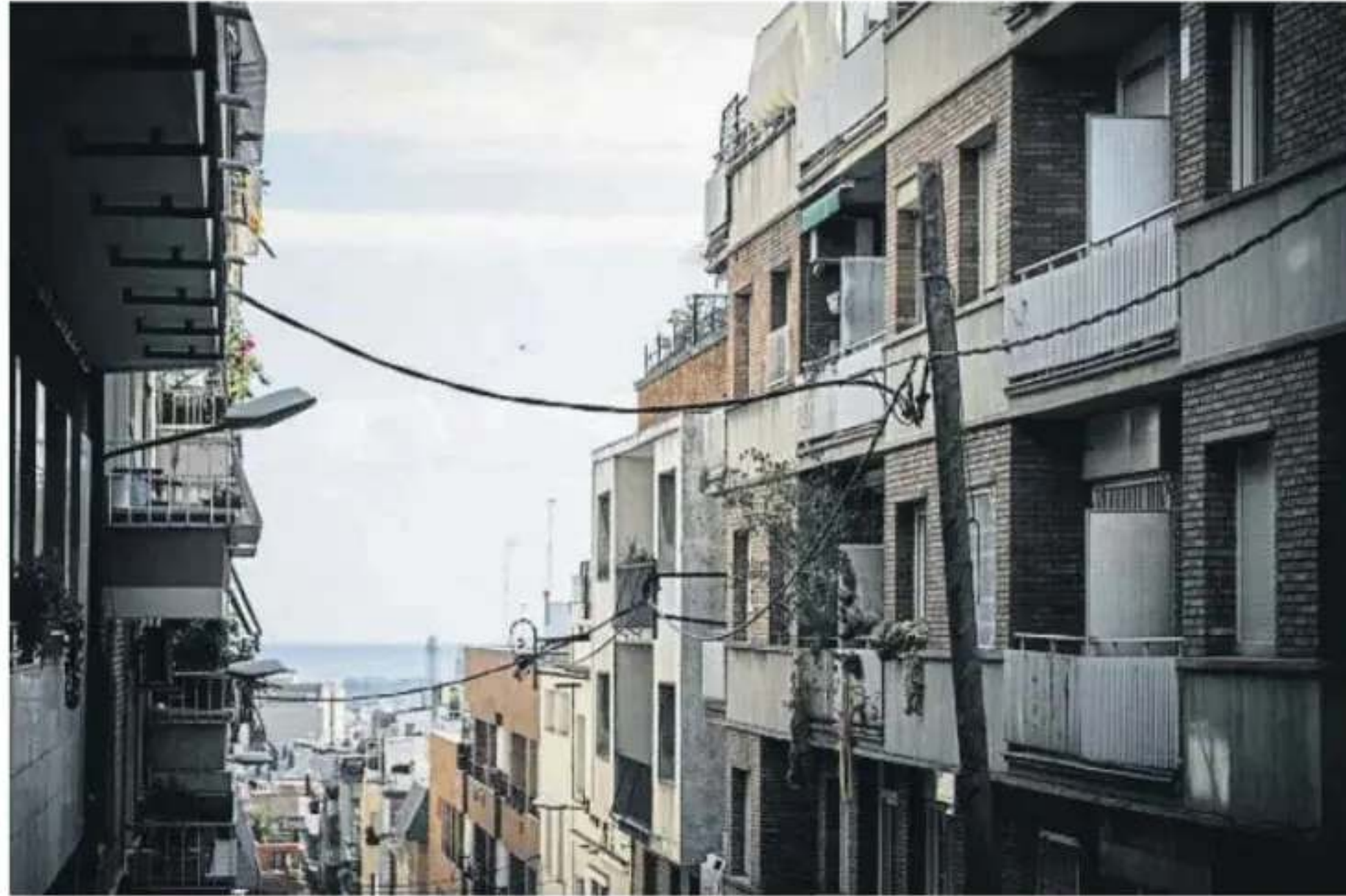
Cables en las fachadas o suspendidos entre edificios afean el paisaje urbano
